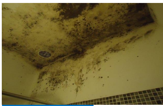
Observations lors de visites à domicile : infiltrations, moisissures et aération encrassée
