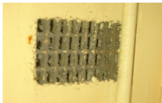
Observations lors de visites à domicile : infiltrations, moisissures et aération encrassée
